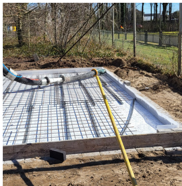
Deel van de nieuwe fundering.
